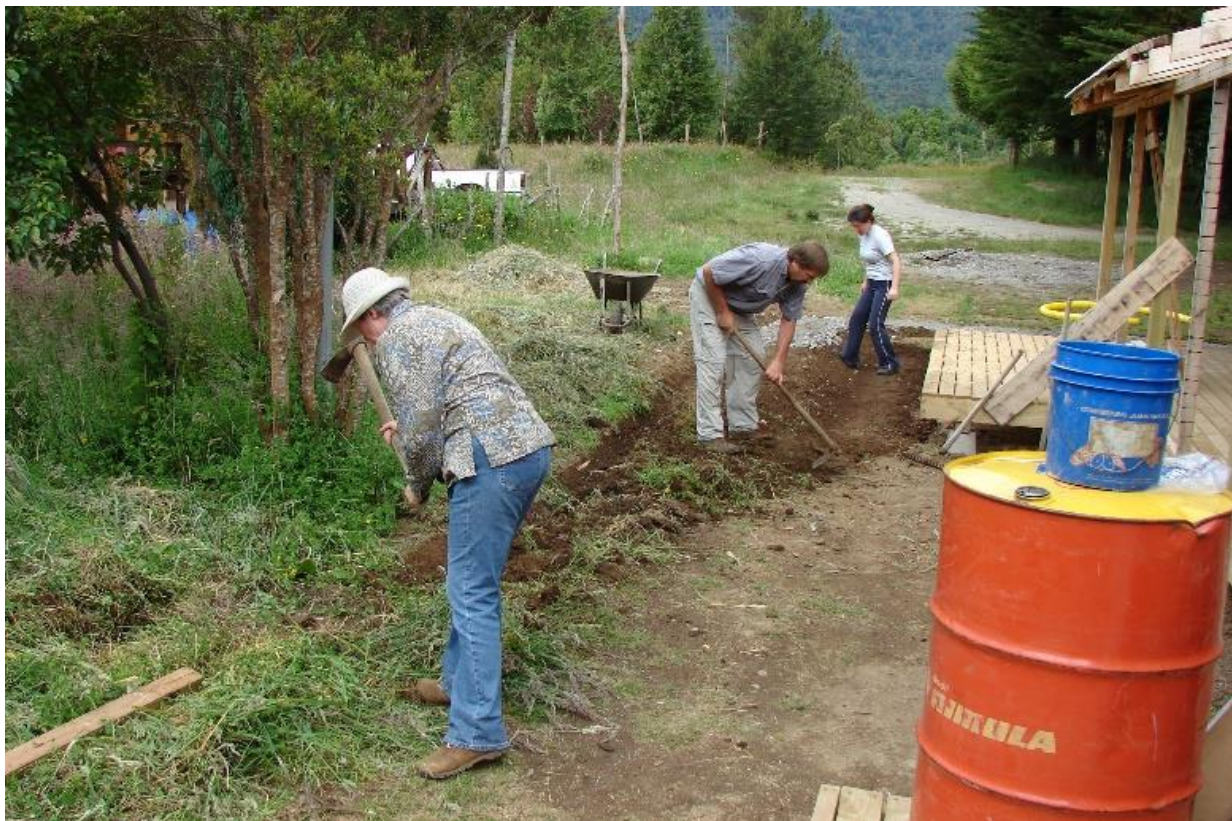
Figura 17: Trabajando frente al quincho, 2008.
